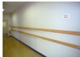
新たに設置した手摺(静岡工場)
